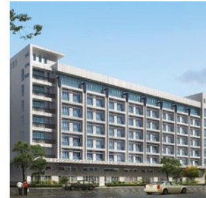
Niższe budynki wielkopowierzchniowe
